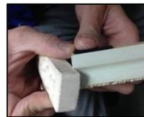
Для коррекции торца, потереть твердой мастикой непосредственно об угол для нанесения (см. фото). Затем, при помощи шпателя, аккуратно выровнять поверхность, удалив излишки мастики. Мы рекомендуем немного сгладить сам торец во избежание отслоения мастики, а также для более удобной покраски угла. Стереть остатки мастики около шва сухой чистой тканью или салфеткой.
